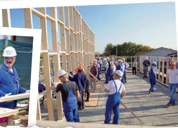
*TAG 1: Endlich geht's los! Nach einer Sicherheitsunterweisung arbeiten Kleingruppen zusammen, um die Holzbretter zu konfektionieren, das Gerüst aufzubauen oder Teile der Wandkonstruktion zusammenzunageln. So nimmt schon am ersten Baudtag die erste Etage Gestalt an. Es stellen sogar die ersten Innenwände und die Raumaufteilung ist bereits zu erkennen.*
